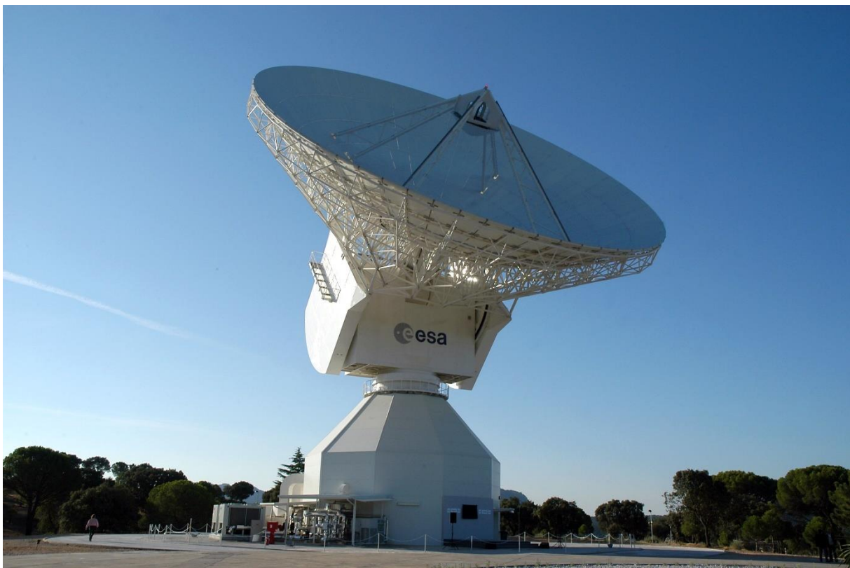
Figur 2: DSA-2, ESAs deep-space antenne med en diameter på 35 m. Kilde: ESA
